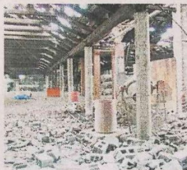
La fabbrica distrutta dal rogo
