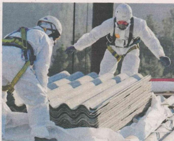
LA BONIFICA del pericoloso amianto (immagine di repertorio)
