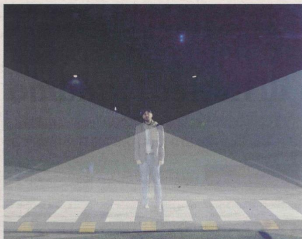
LA FOTOGRAFIA TESTIMONIA COME FUNZIONANO GLI IMPIANTI INTELLIGENTI
