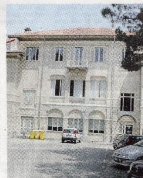
Nella fotografia a sinistra l'interno di un asilo nido (repertorio) a fianco il municipio di Vigliano Biellese
